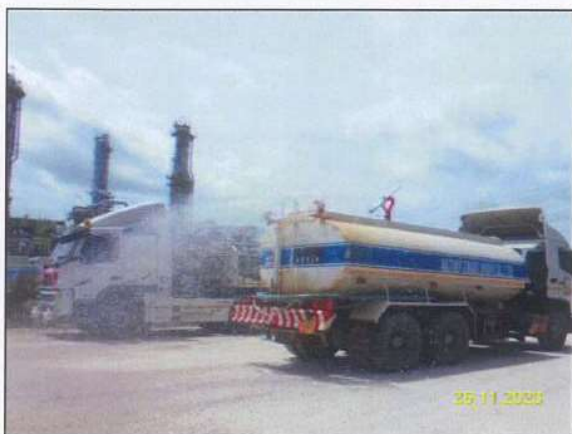
รูปที่ 2-3 การฉีดพรมน้ำเพื่อลดการฟุ้งกระจายของฝุ่นละอองและทำความสะอาดถนน
