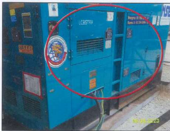
ก) ตู้เหล็กครอบเครื่องยนต์เพื่อลดระดับเสียง
