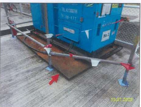
รูปที่ 2-9 การจัดเตรียมอุปกรณ์ป้องกันการรั่วไหลของน้ำมัน
