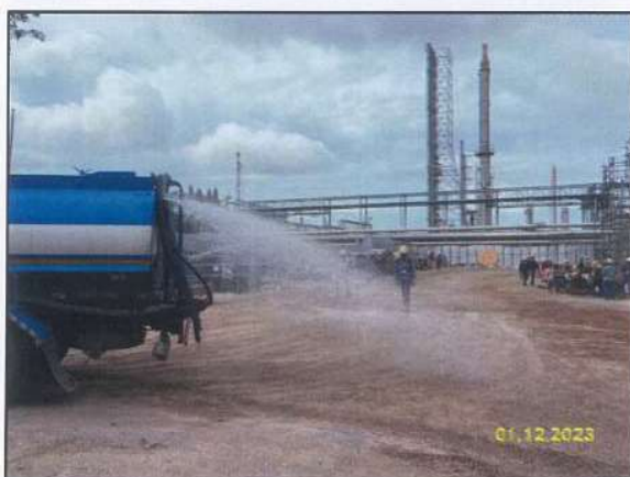
รูปที่ 2-3 การฉีดพรมน้ำเพื่อลดการฟุ้งกระจายของฝุ่นละอองและทำความสะอาดถนน
