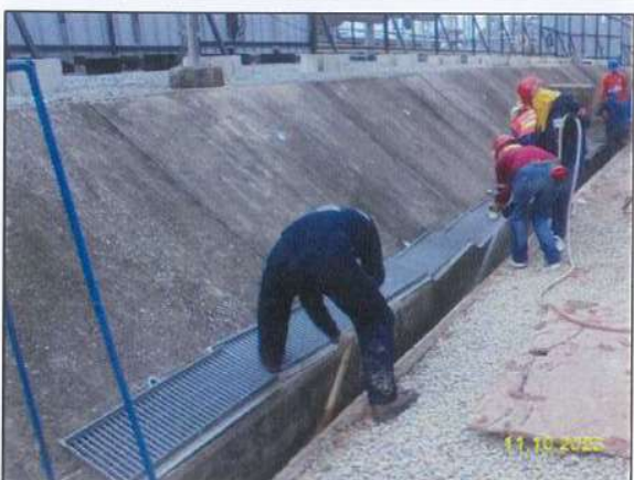
รูปที่ 2-8 การตรวจสอบและดูแลชุดลอกดินตะกอนดินในรางระบายน้ำฝน
