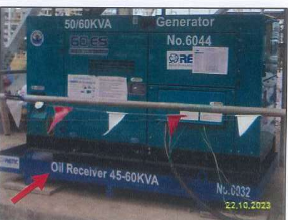
รูปที่ 2-9 การจัดเตรียมอุปกรณ์ป้องกันการรั่วไหลของน้ำมัน
